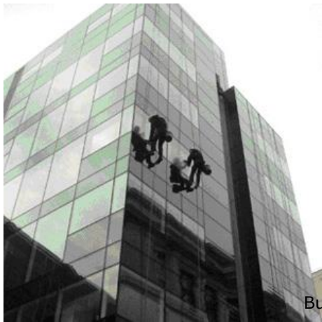
Buenos Aires SHERATON HOTEL Trabajos de altura – 3.000m 2
