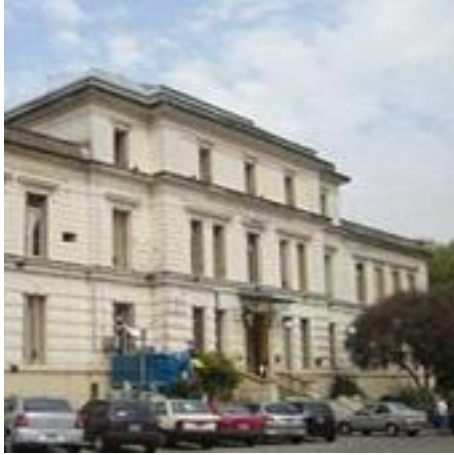
Hospital Moyano – Mantenimiento de equipos centrales de Pabellones 800 TR
